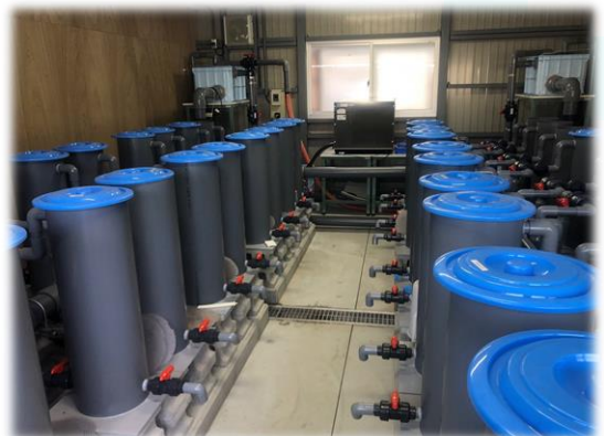
新設した卵管理棟
