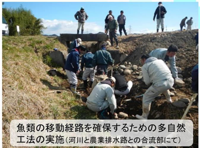
魚類の移動経路を確保するための多自然工法の実施(河川と農業排水路との合流部にて)
