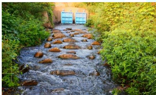
施工後(根固めブロックによる斜路式魚道)
