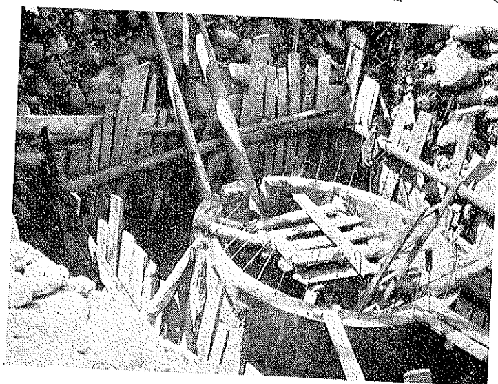
写真 5 建設中の第2号井戸
