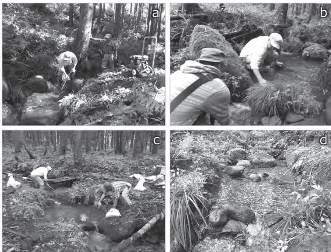
第 2 図 桂清水の沢における人工産卵場の造成作業(aは底面の掘削および堆積土砂の除去作業、bは礫止めの配置作業、cは大礫および砂利の敷設作業、dは完成した人工産卵場)
