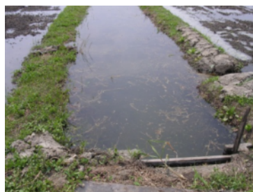
水路と水田に落差のない水路の例 魚は水田にも移動できる
