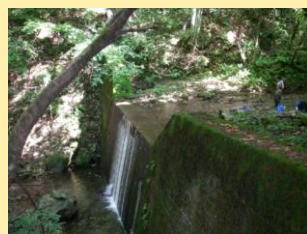
古い堰堤（種苗放流が始まる前の時代に設置された堰堤）の上流側
